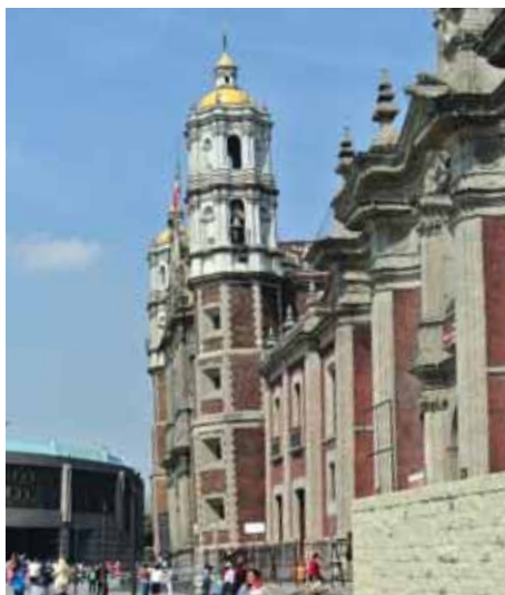
Widoczne przechylenie wież starej bazyliki
